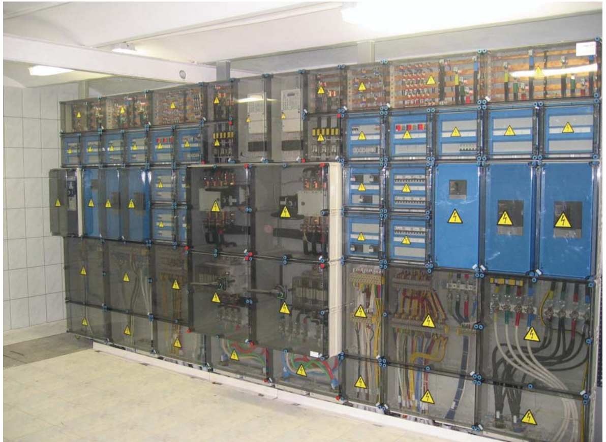
Mİ Panolardan imal edilmiş bir ana jeneratör panosu
